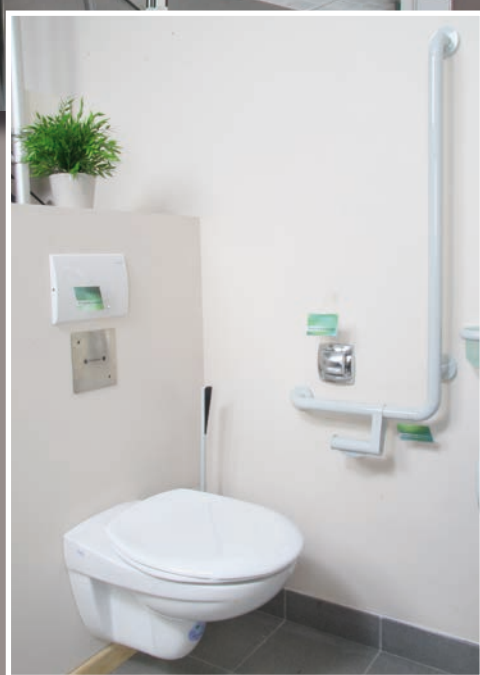
Un wc rehaussé et accessible de côté, avec commande de chasse d'eau latérale.
