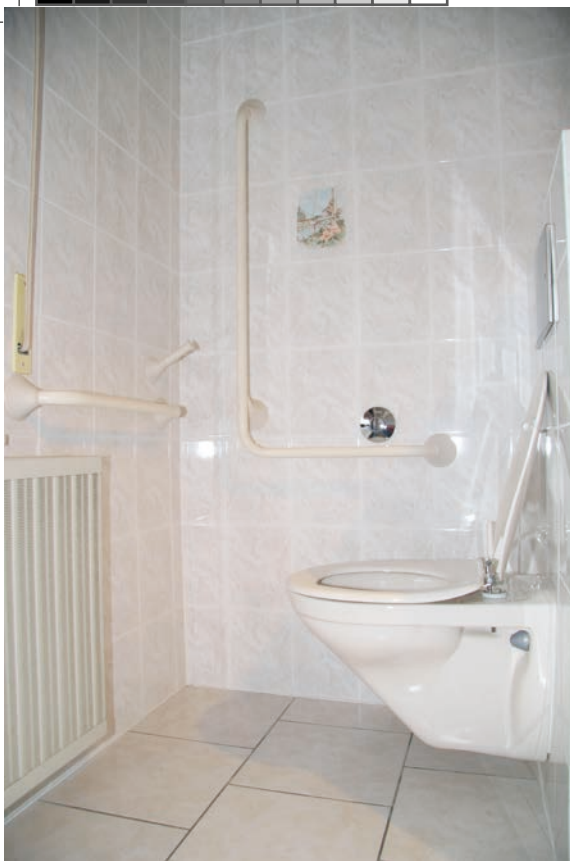
Un WC accessible par le côté - une hauteur légèrement re- haussée - une barre du côté dominant - une commande de la chasse d'eau latérale
